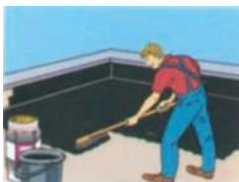
Aplikace penetrace za použití koštěte.
