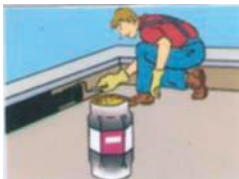
Aplikace penetrace pomocí válečku.
